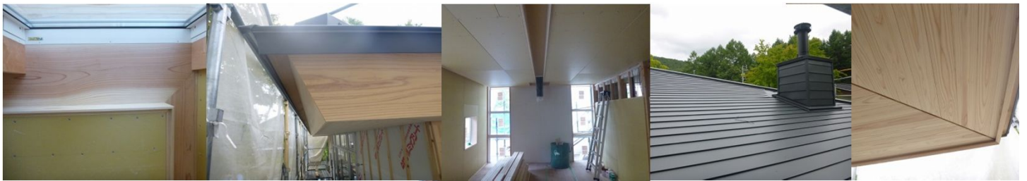
下部写真 工事中のFLAT 現場写真
