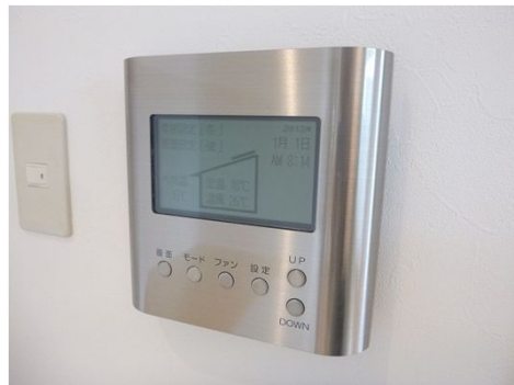
コントローラ 夏・冬・外気取り入れ・室内循環の 4モード
