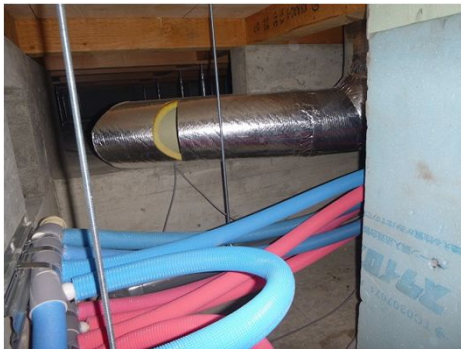
床下吹き出し口 基礎コンクリートに蓄熱を行います。 夜間にゆっくり放熱されます
