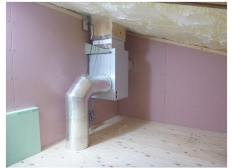
ソーラーファンボックス 集熱運転と室内循環に限定したシンプル運転 先々のメンテナンスに配慮したシンプル構造
